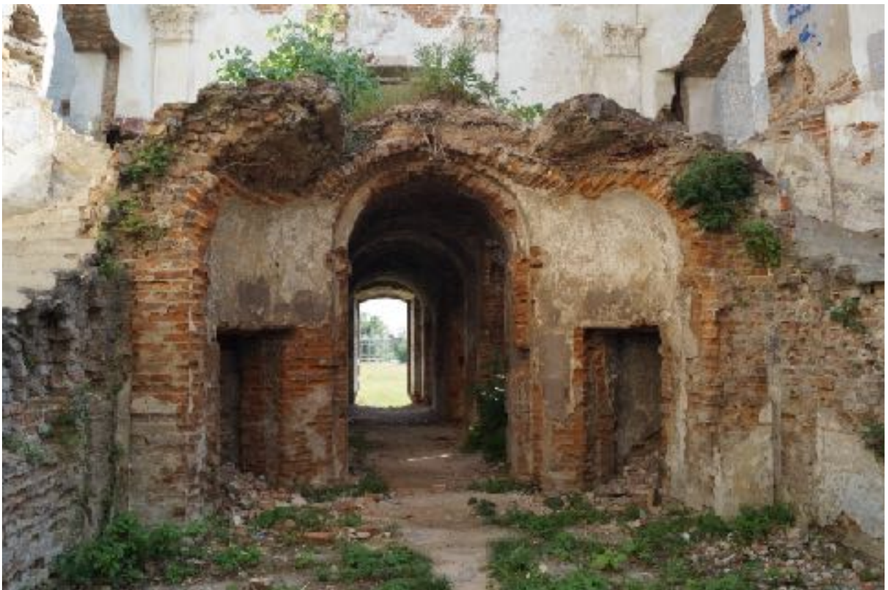
Fragment zrujnowanej części centralnej pałacu Zasławskich.
